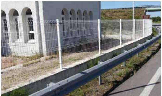
**Característiques:** panells de malla electrosoldada fabricada amb vareta galvanitzada, que posteriorment es recobreix amb tractament de polièster. Panell de 2,50m amb varilla de 5mm y 200x50.
